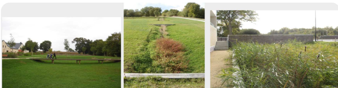
Exemple de bassins paysagés et noues plantées
